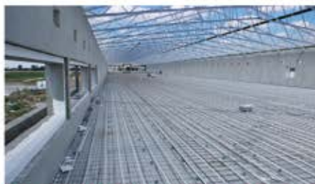
Instalacja KAN-therm ogrzewania hall kurnika (2500 m 2 ) hodowli ściółkowej - Brzozowo Wielkie.
